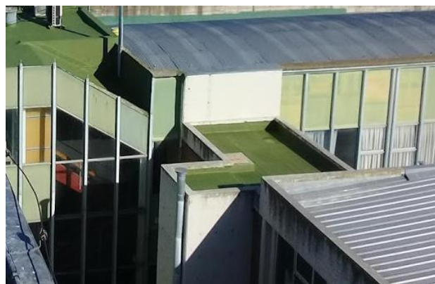
Muro donde instalar nueva escalera
