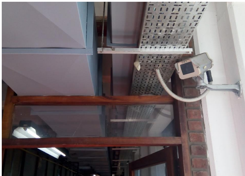
PASE POR VIDRIO DE BANDEJA EXISTENTE
