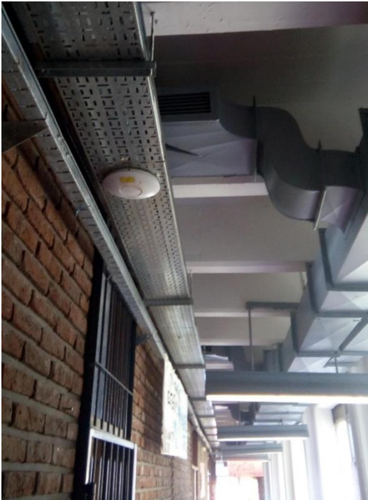
BANDEJAS PORTA-CABLES EXISTENTES con DOBLE VARILLA ROSCADA
