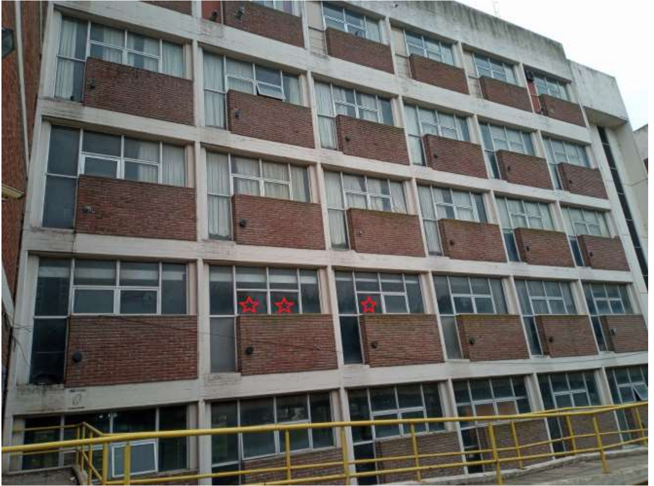
3 Ventanas sobre fachada calle Guido, pabellón Humanidades
