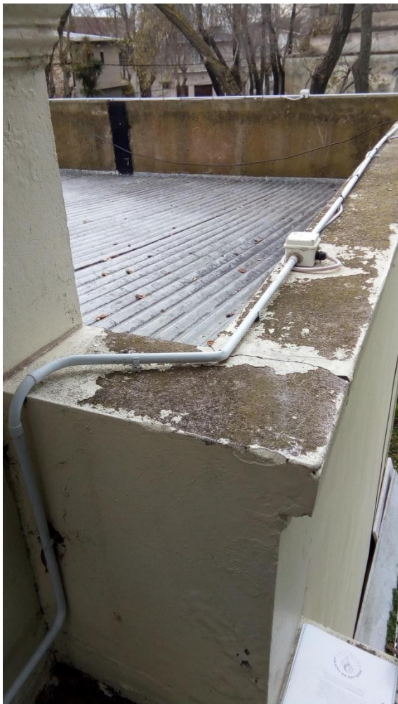
Reubicacion de instalación eléctrica
