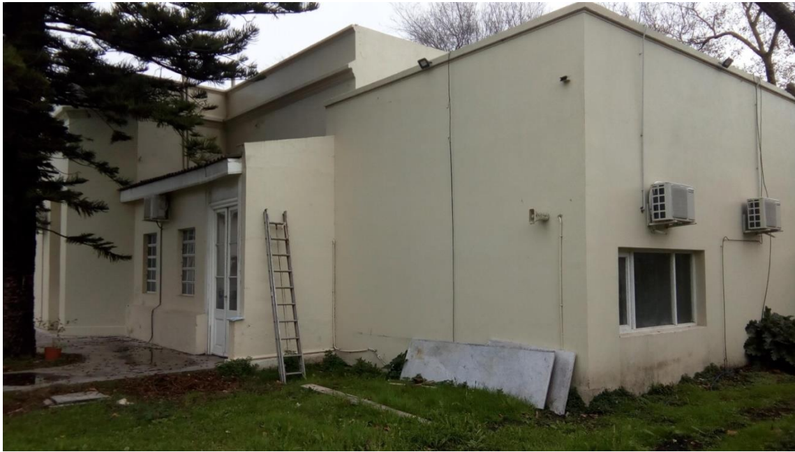
Fachada interna Casa Jara
