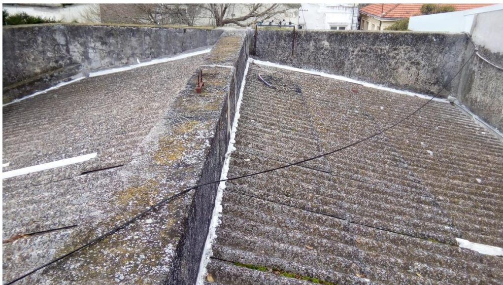
ESTADO ACTUAL TECHO DE FIBROCEMENTO
